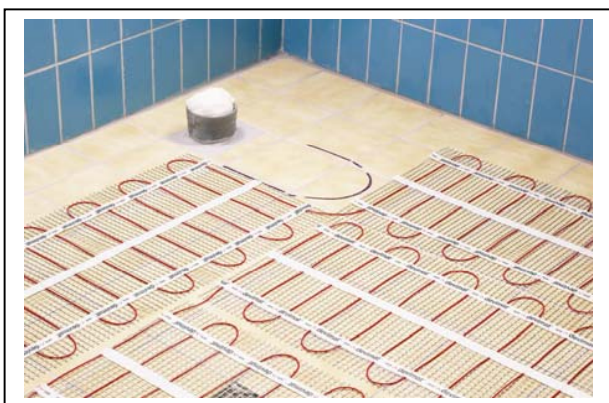
Рис. 3. Монтаж нагревательного мата devimat™ DTIR в ванной комнате на старую плитку.
