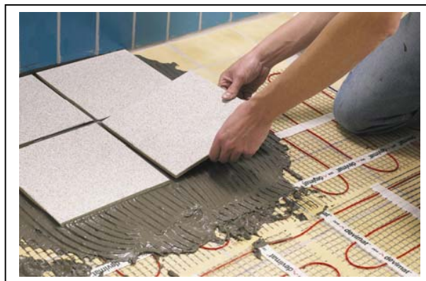
Рис. 3. Монтаж нагревательного мата devimat™ DTIR в ванной комнате на старую плитку.
